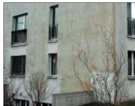
3.2.7 Infestazione di alghe a causa della mancante protezione costruttiva contro le intemperie.
