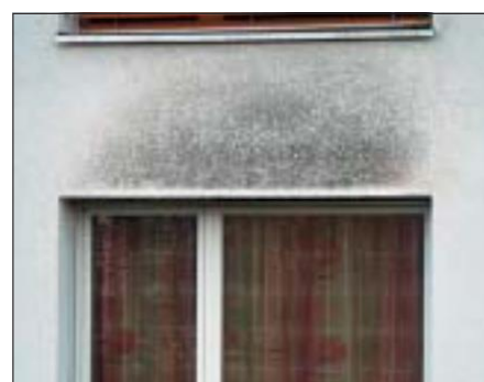
3.2.7 Infestazione di alghe a causa della mancante protezione costruttiva contro le intemperie.
